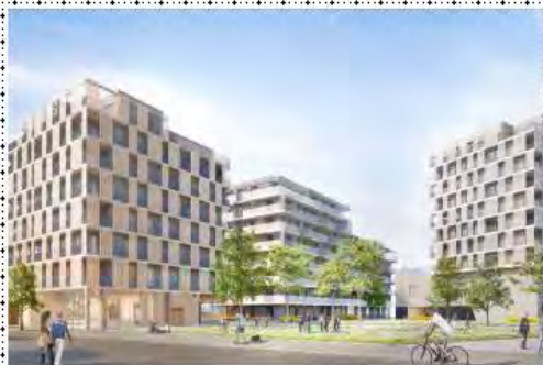
Wohnbau Le Lac Sportif – Quartier am Seebogen!
