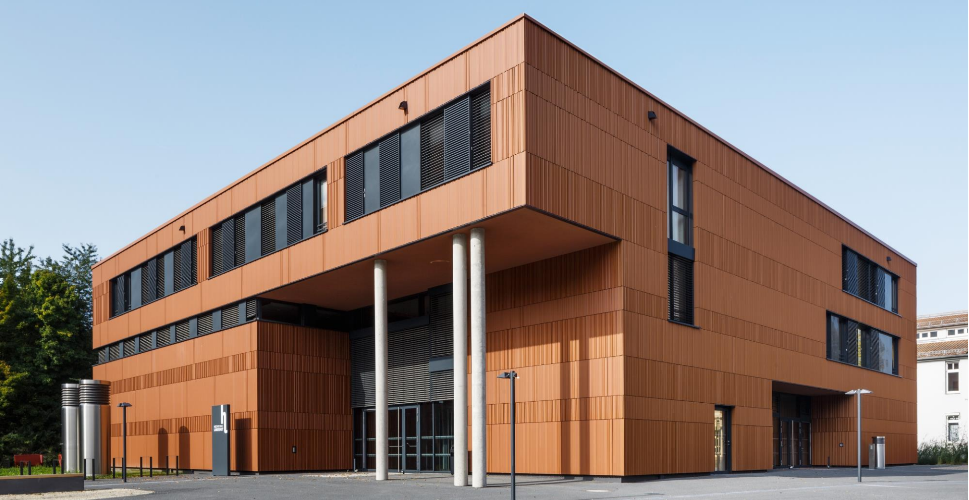
Hörsaal- und Verwaltungsgebäude HS Landshut , POS architekten 2017 Passivhaus Hülle, natürliche Kühlung mit Nachtlüftung, Photovoltaik
