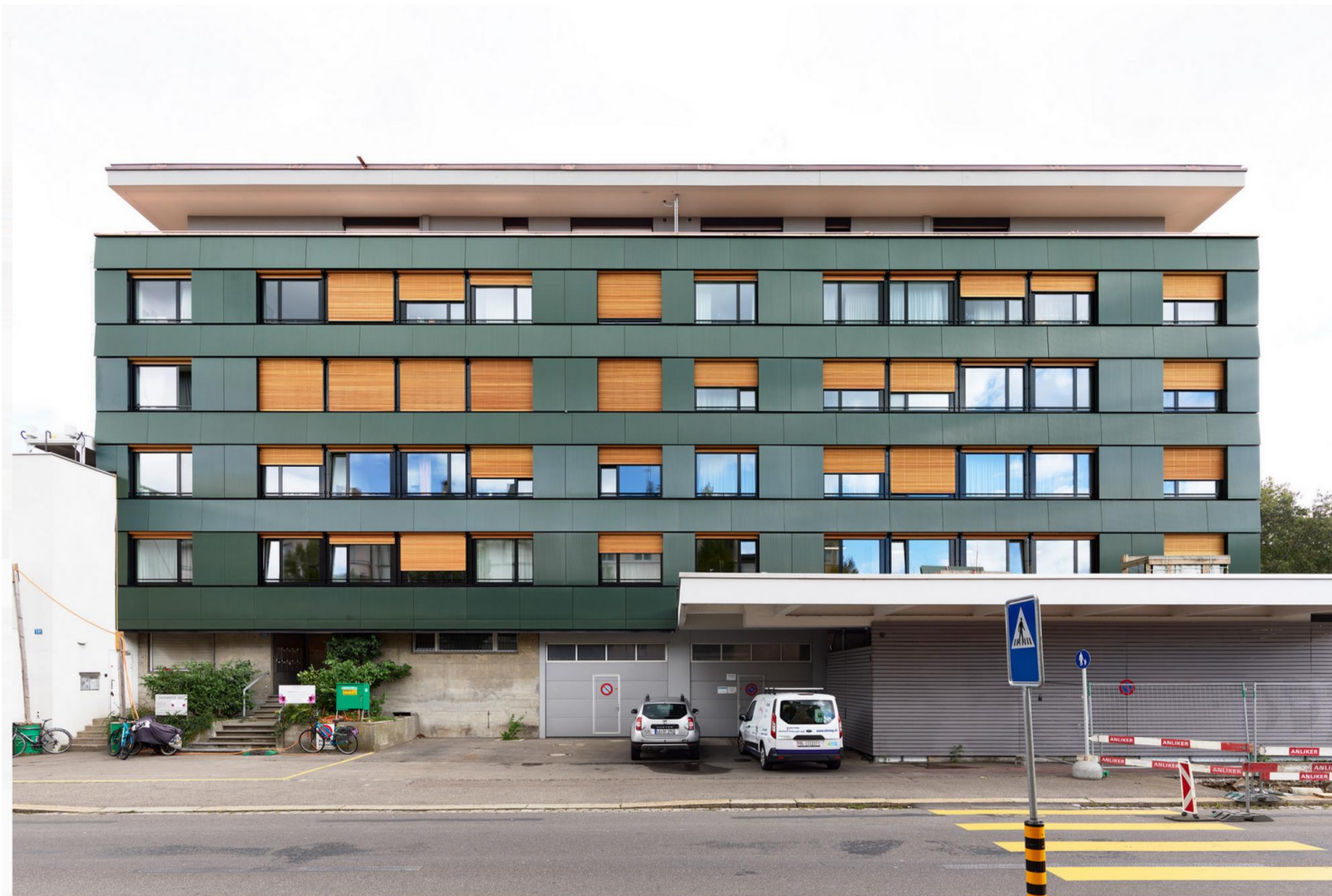
Sanierung, Salathé architekten, Basel Komplette Fassade aus PV Modulen
